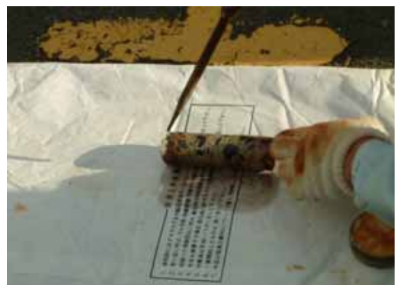
図-13 亜硝酸リチウム浸透確認
