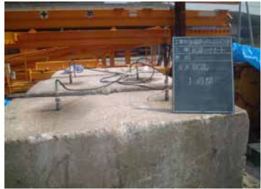
図-7 試験施工状況
