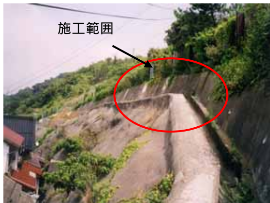
図-9 日御碕擁壁施工箇所
