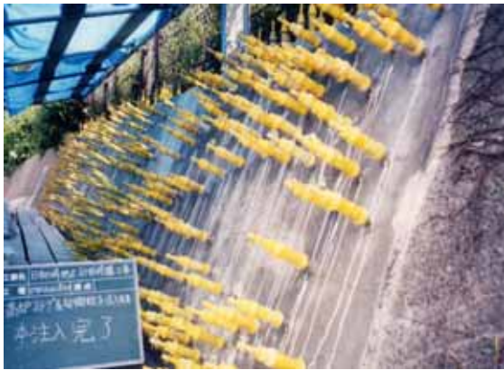
図-11 ひび割れ注入状況
