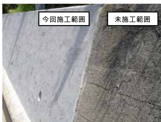
図-14 施工完了状況
