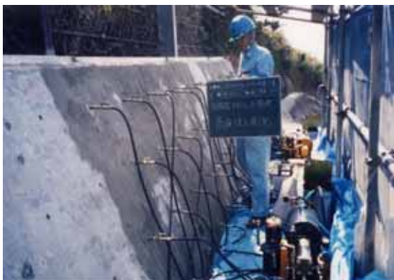
図-12 高圧注入工施工状況
