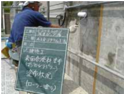
写真-13 表面保護工（含浸工法）
