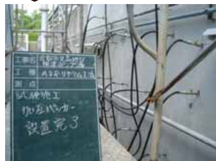
写真-10 加圧パッカー設置工
