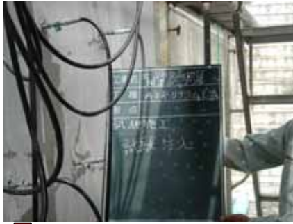
写真-11 加圧注入工
