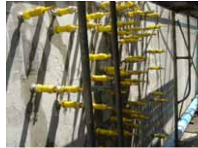
写真-7 表面漏出防止工
