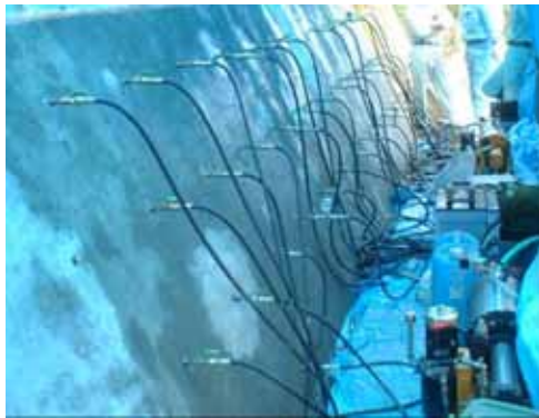
写真-14 施工状況（擁壁）
