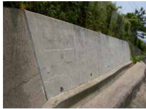
写真-15 外観状況（擁壁：2年半後）
