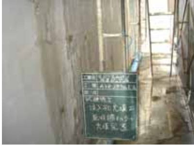
写真-12 圧入孔充填工
