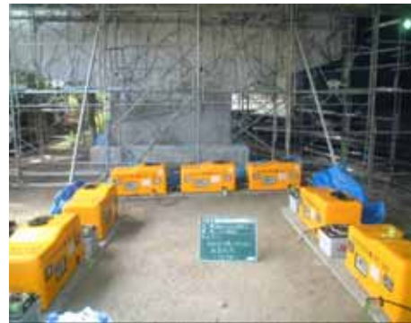
写真 - 16 施工状況
