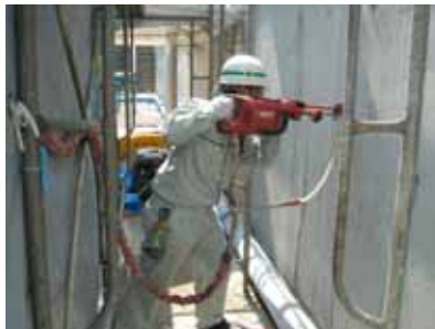
写真-9 削孔工
