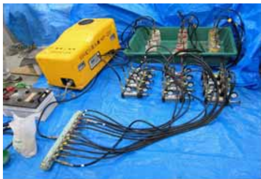
図-1 内部圧入工状況
