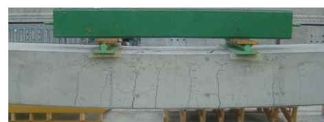
写真-1 供試体Sのひびわれ発生状況
