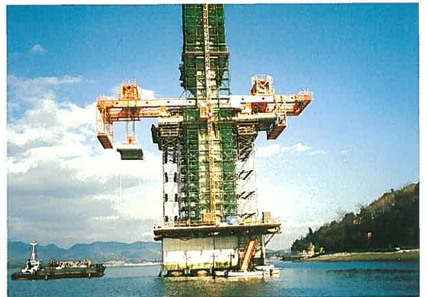
主桁架設状況
