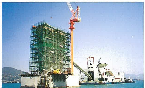
橋脚 コンクリート打設状況
