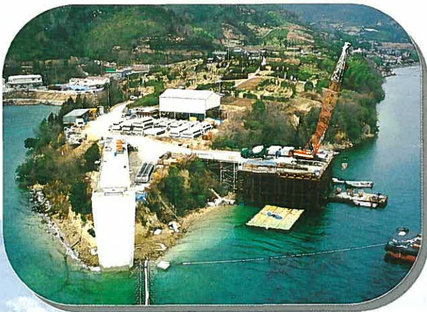
◀主桁製作仮置きヤード
