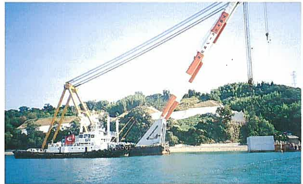
P5フーチング プレキャスト枠設置状況
