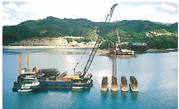
鉄筋籠建込状況
