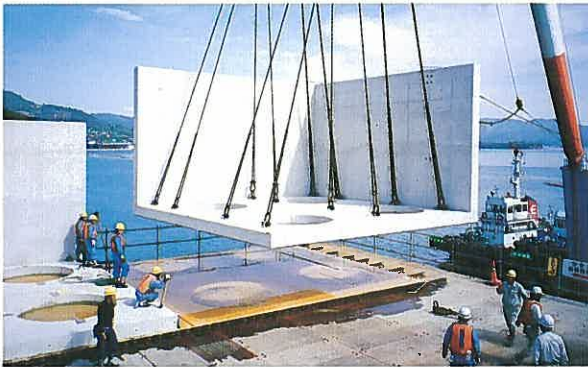
P5フーチング プレキャスト枠設置状況
