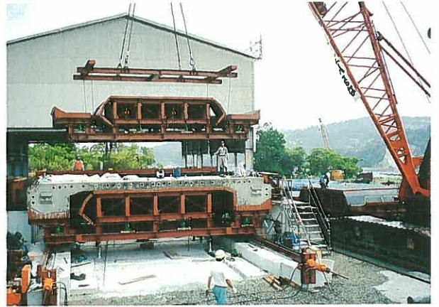
主桁製作状況
