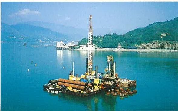
基礎杭施工状況
