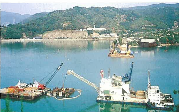
基礎杭コンクリート打設状況
