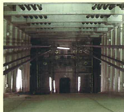
外ケーブル配置事例 External cable arrangement
