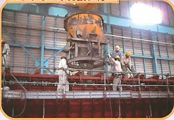
コンクリート打設状況
