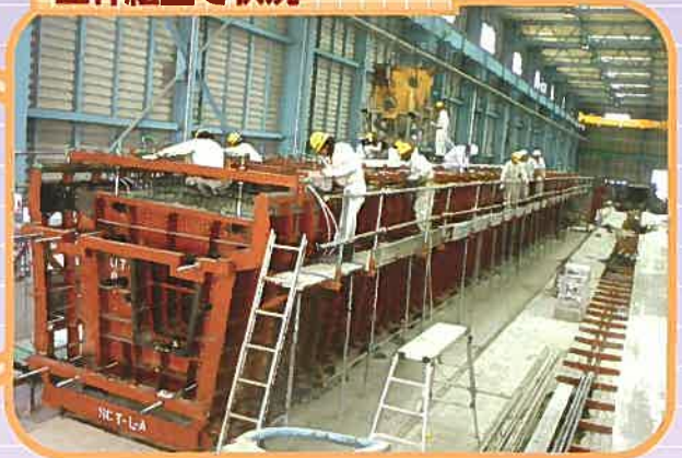
型枠組立て状況
