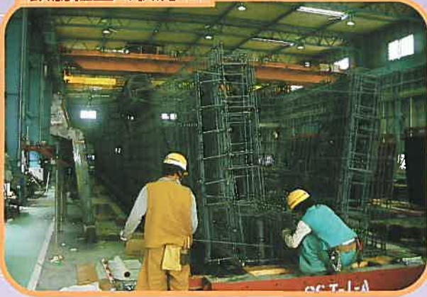
鉄筋組立て状況
