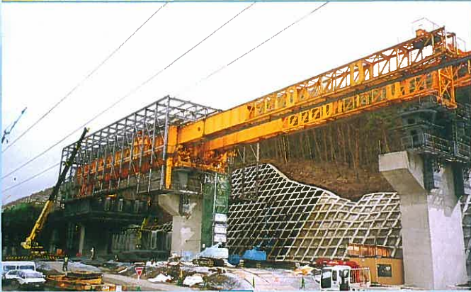
1 移動支保工組立
