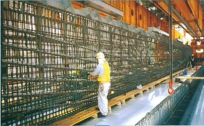
3 鉄筋PCケーブル組立
