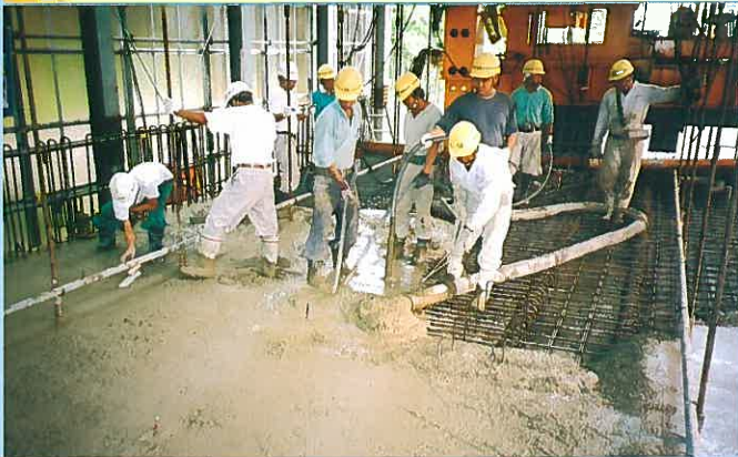
4 コンクリート打設
