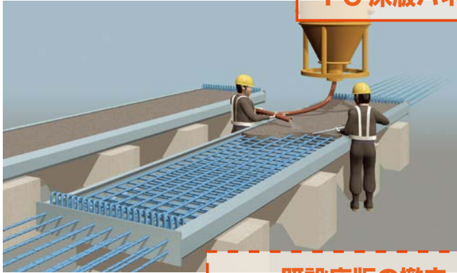
床版パネルの工場内製作
