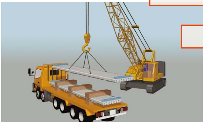
床版パネルの現場への搬送
