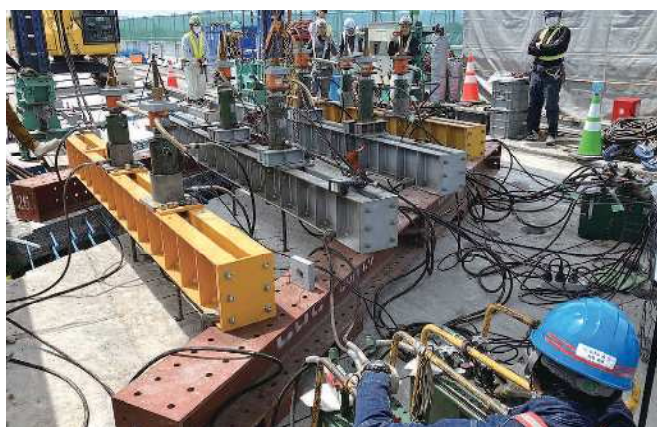
▲RC床版と鋼桁の分離状況
