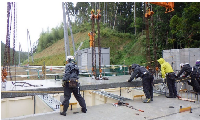
【プレキャスト床版架設写真】
