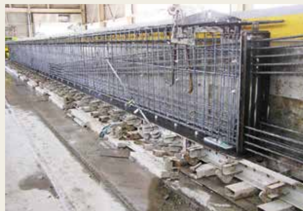
PCT桁（プレテンション方式）
