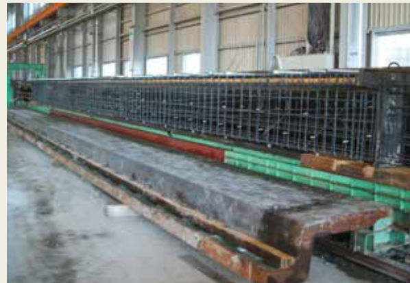
プレテンション方式 PC 桁
