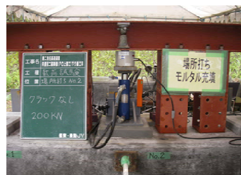
載荷試験状況
