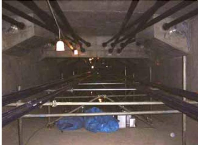
外ケーブルの防錆としてエポキシ被覆PC鋼材を使用しています。
